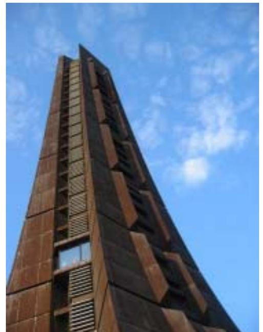
街であまり見ないが メンテナンスのしにくい山間部の橋梁などに使われその耐食機能を発揮している。でも この耐候性鋼 サビが付着安定するまでに時間が必要で それまでは サビが流れ出し、まわりを汚すので無塗装での使い道がその後伸びず苦労した材料。
