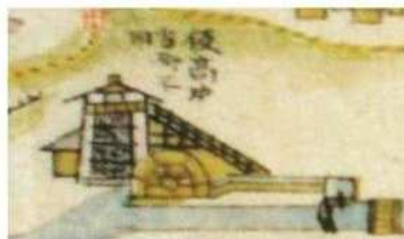
改修により三番高炉が築造された仮高炉
