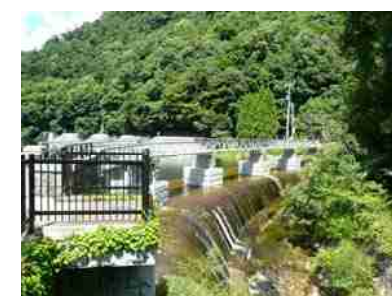
国の重要文化財 布引溪谷・布引ダム沿いの煉瓦積・石積み取水・分水堰堤等の水源地諸設備
