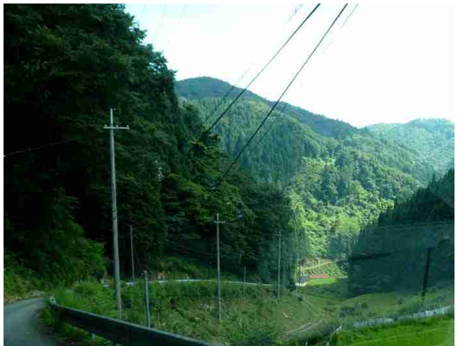
小茅野集落から集落の入口方向 集落への登り道を眺める 写真右端中央が県道 520 赤い屋根が公民館
