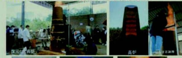
炎で操作管理しつつ、炉頂より鉄鉱石と木炭交互に繰り返し投入して層状に積み重ね炉内溶融反応製錬
