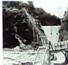
【工事中】川底より工事材料を上げるための足場の状況
