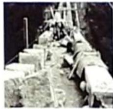
【工事中】良地の石を使って天端の工事状況
