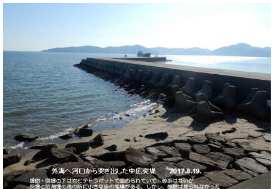
加里屋川河口東岸の先端 google earthより 河口から海へ中広突堤が突出し、東には千種川の西岸まで、強固な防潮堤が伸びている
