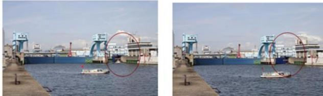
副水門閉鎖作業中 → 副水門完全閉鎖
