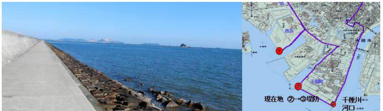
防潮堤は陸側も含め、三段の巨大なもので岩で固められ、砂州などは千種川の河口まで全く見えない。街の人によれば、赤穂の沿岸は埋め立て、沿岸の出入りがなくなり、外海の流れを遮れないので、砂は余計に堆積しなくなっていると。 港の機能としては深くていいのでしょうか・・・
