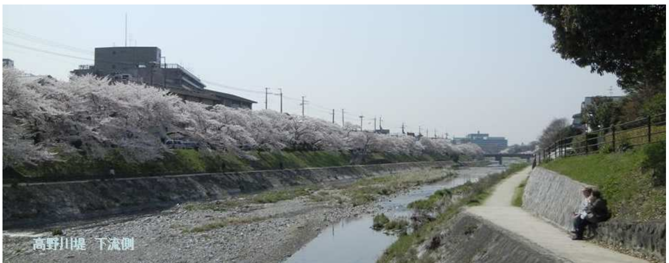
高野川堤 上流側
