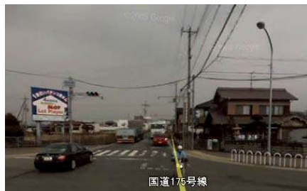
国道175号田井南交差点(南より)
