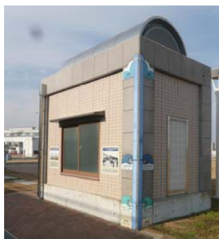
地盤沈下計測所
