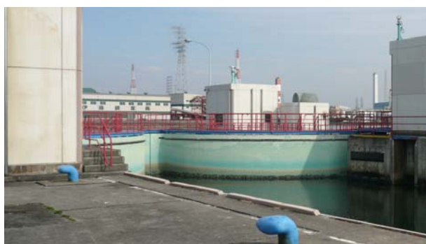
水門の港外側
