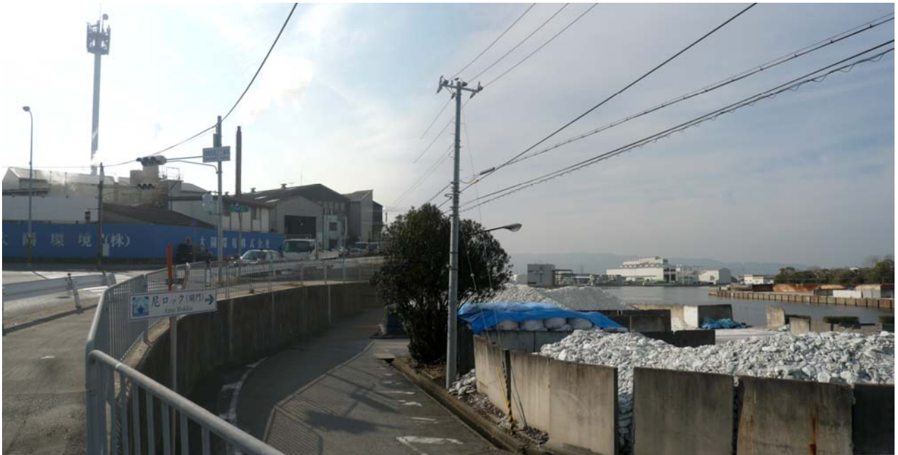
大高洲から 旧防潮堤に沿って 西へ 右手奥に尼崎港閘門・尼崎ロックがみえる
