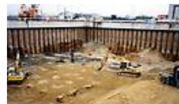
仮締切堤内での施工状況 （ドライワーク）
