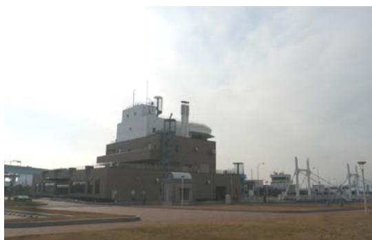
集中コントロールセンタ 後 第一閘門
