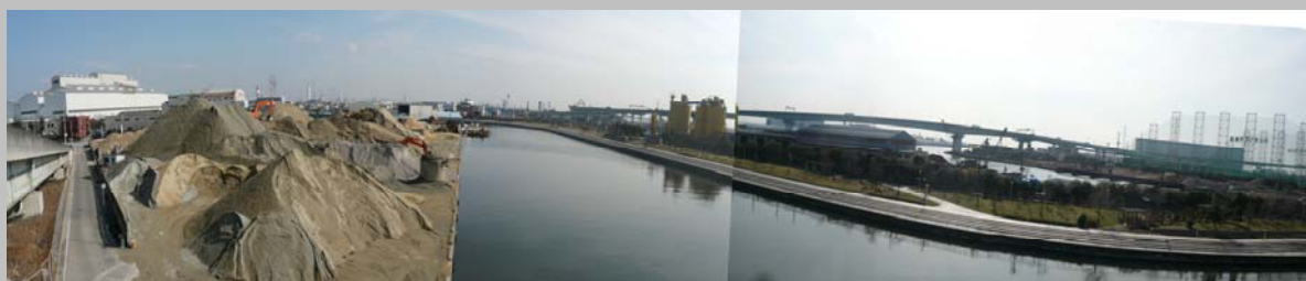
高架橋の東側 運河の左沿い奥が尼崎港閘門 正面が大阪湾を渡る阪神高速湾岸線 右端 パナソニックの大工場
