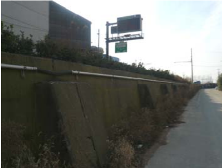
大高洲 旧防潮堤
