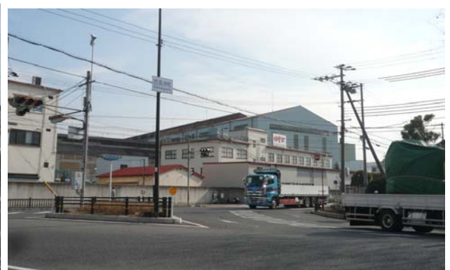
西高洲町のト字交差点東側の住友チタニウム
