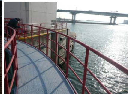
尼崎港第一開門 水門
