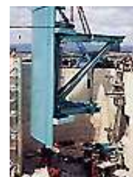
門扉取付状況
