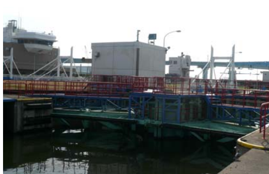
水門の港内側
