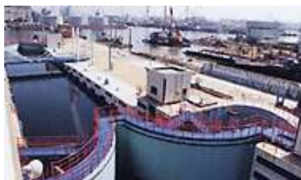
新第2閘門（平成6年度完成）
