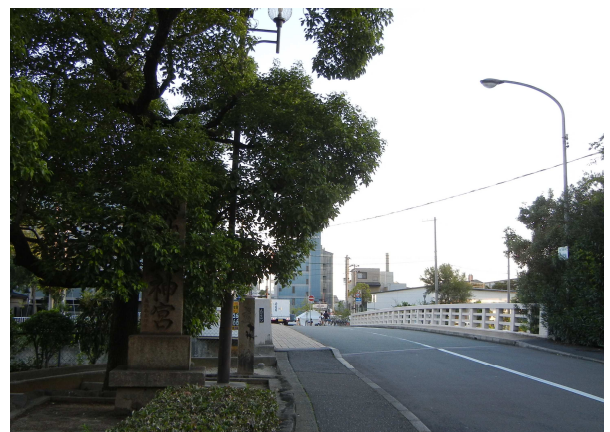
すぐ南側 東西の水路に架かる築地の西入口 戒橋
