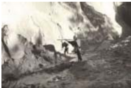
山砂切り崩し
