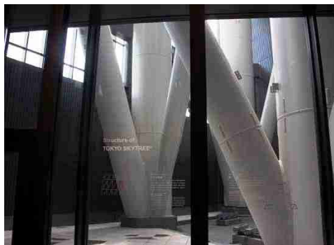
図4●塔体最下部に使用された鋼管 建築現場に納入する際には、分岐する鋼管をあらかじめ溶接・塗装した状態で運び込む。(写真：大林組)
