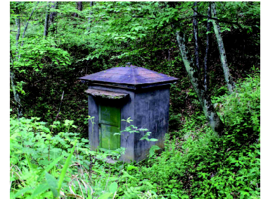
火薬庫／暴発に備え土塁を築いた中に建ててある
