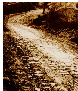
河原石を敷き詰めた鉄山線道路
